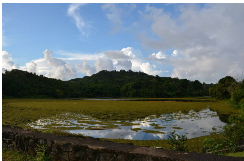
Figure 13 : Retenue collinaire de Combani.
